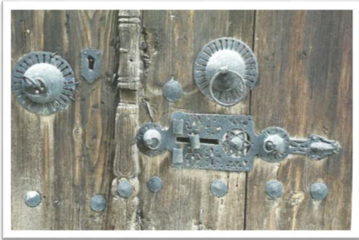
(Res.17) Eski madenî kapı açma düzeni ve şakşakları (2008)
